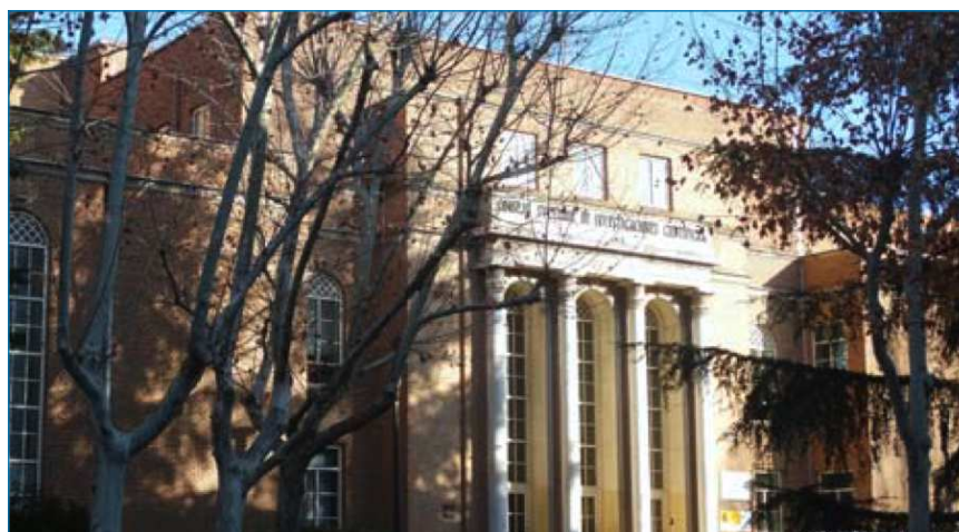
Figura 2. El Edificio Rockefeller en la actualidad (sede del Instituto de Química Física “Rocasolano” del CSIC)
