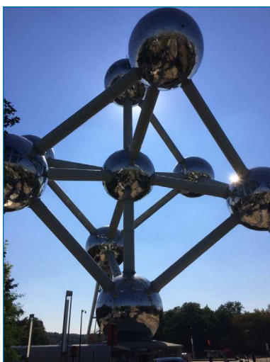
Figura 18. Situado en el parque de Heysel en Bruselas (Bélgica), se encuentra el monumento llamado “El Atomium”, formado por una estructura de 102 metros de altura construida para la Exposición de Bruselas de 1958. Representa un cristal de hierro
