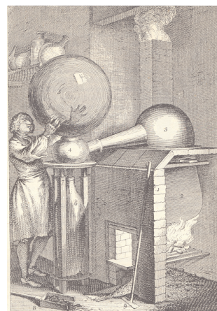
Figura 4. Alrededor de 1740 el curandero inglés Joshua Ward (1685–1761) mejoró notablemente la fabricación de ácido sulfúrico reemplazando la campana por grandes globos de vidrio, los cuales reducían enormemente las pérdidas de gases de \text{SO}_2 y \text{SO}_3 . No mucho después los frágiles recipientes de cristal fueron reemplazados por cámaras de plomo. Fuente: C. Singer, The Earliest Chemical Industry , The Folio Society, London, 1948, p. 274.
