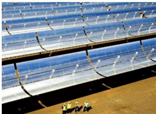
Figura 7. Colectores de tipo canal parabólico (Fuente: Wikipedia).
