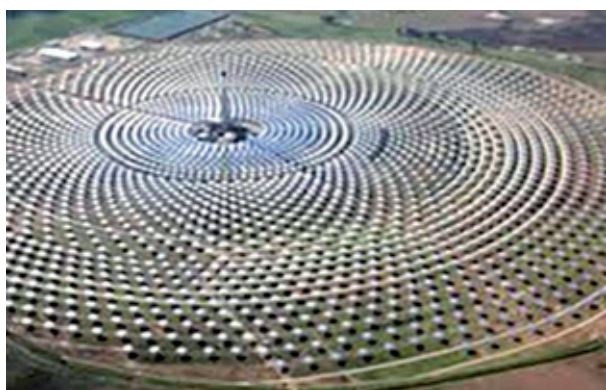
Figura 8. Central solar de torre con heliostatos (Fuente: Wikipedia).
