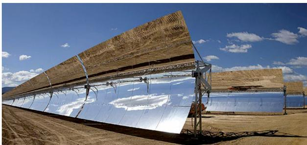
**Figura 7.** Colectores cilíndrico-parabólicos captadores de energía solar térmica de media temperatura.
