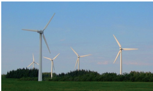
Figura 11. Campo de aerogeneradores eólicos (fuente: WIKIPEDIA).
