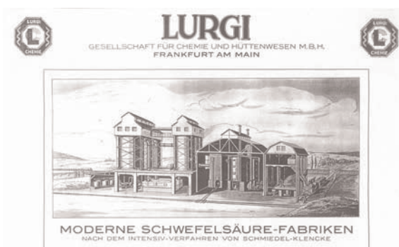
Figura 5. Durante el siglo XX los ingenieros contratistas tuvieron un papel cada vez mayor en la industria química. La compañía alemana Lurgi era líder en el mercado de plantas de ácido sulfúrico como resultado de las grandes mejoras realizadas en hornos de piritas (los llamados hornos Herreshoff). Fuente: Arbeits-Gebiet der Lurgi Gesellschaft für Chemie und Hüttenwesen mbH [Öfen, Schwefelsäure-Anlagen, Phosphorsäureanlagen] , Lurgi Chemie, Frankfurt am Main, 1930.
